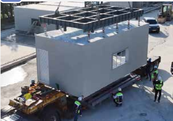
04 운반 및 설치
